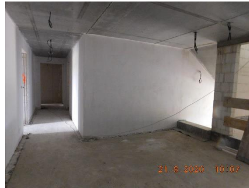
Innenausbau mit ersten Putzarbeiten
