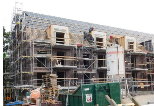
Haus 10 – Dach gerichtet, Eindeckung folgt
