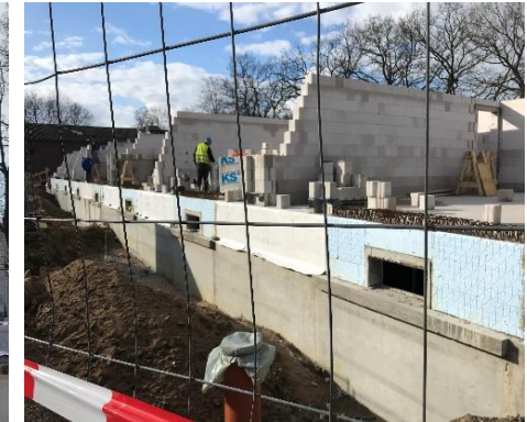
Haus 10 – Tragende Innenwände
