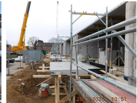
Fertiggestellte Rohbaumontage der Balkone im EG, traufseitig zur Straße
