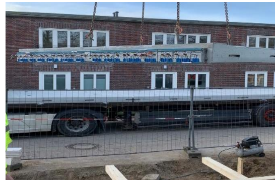
Lieferung hochwertiger Fertigteilbalkone SCHÖCK-Isokorb (zur thermischen Trennung von Innen- und Außenbauteil)
