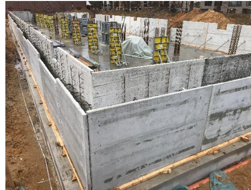
Haus 10 – Betonfertigbauteilwände gestellt
