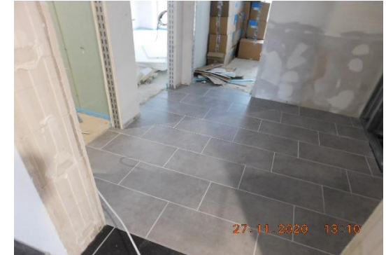
Fliesenarbeiten im Flur
