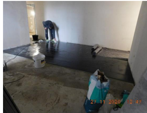
Weitere Bodenarbeiten nach Estrichguss
