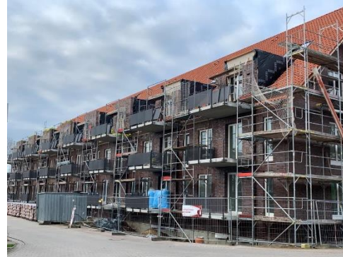
Haus 10 – Fenster eingesetzt
